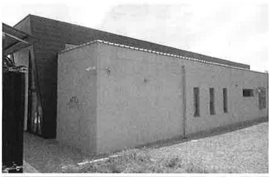
建設中のルンビニー苑事務・浴室棟
