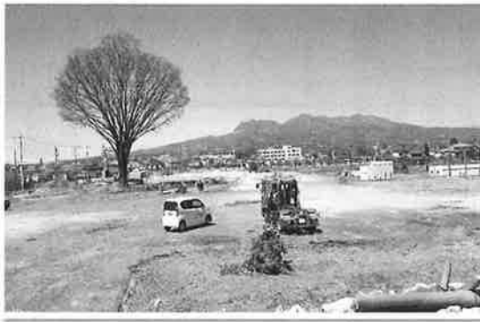
旧群馬県農業技術センター 建物解体後
